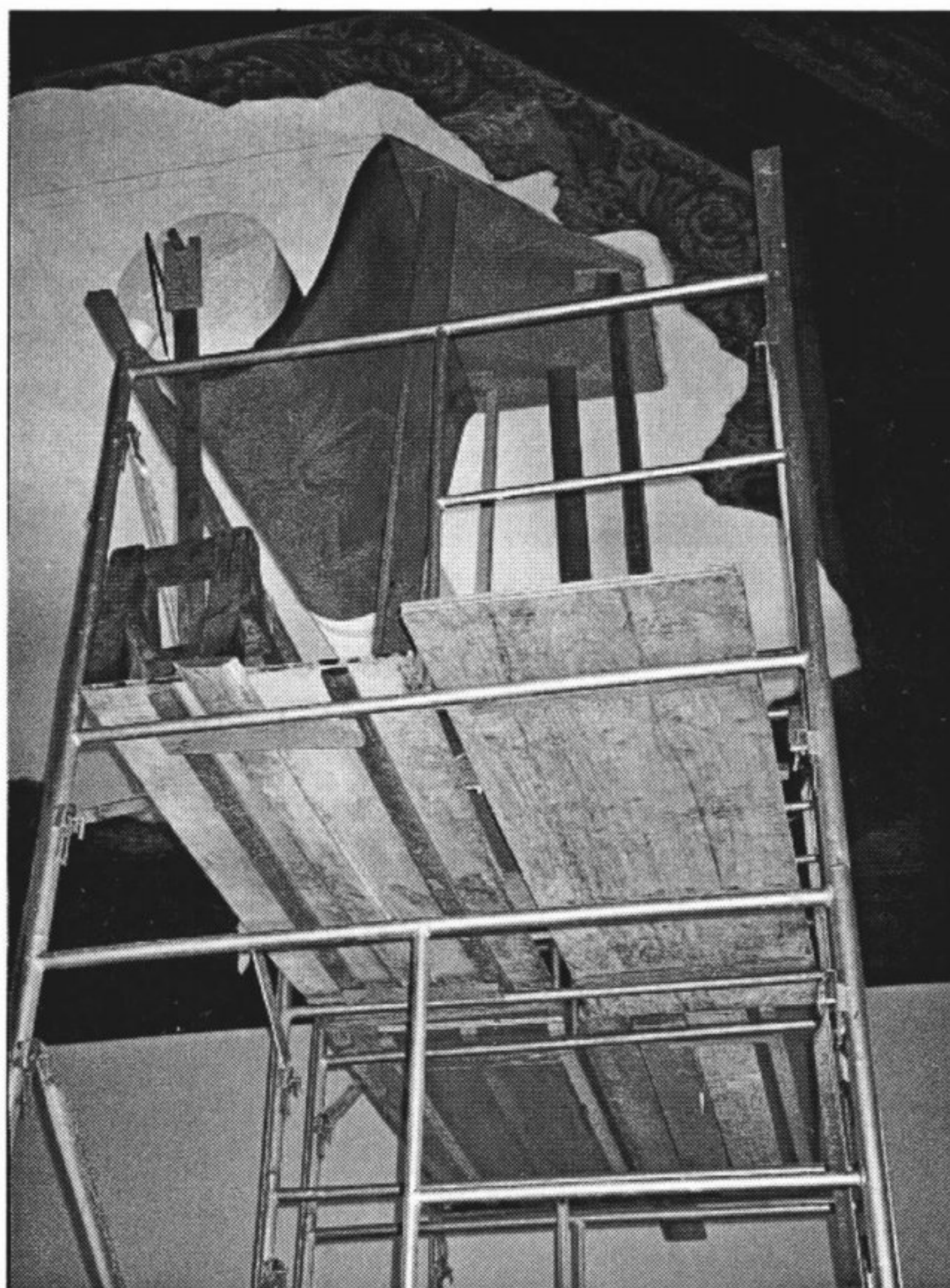
Foto 13 – Fixação das partes da obra ao teto da Biblioteca.
