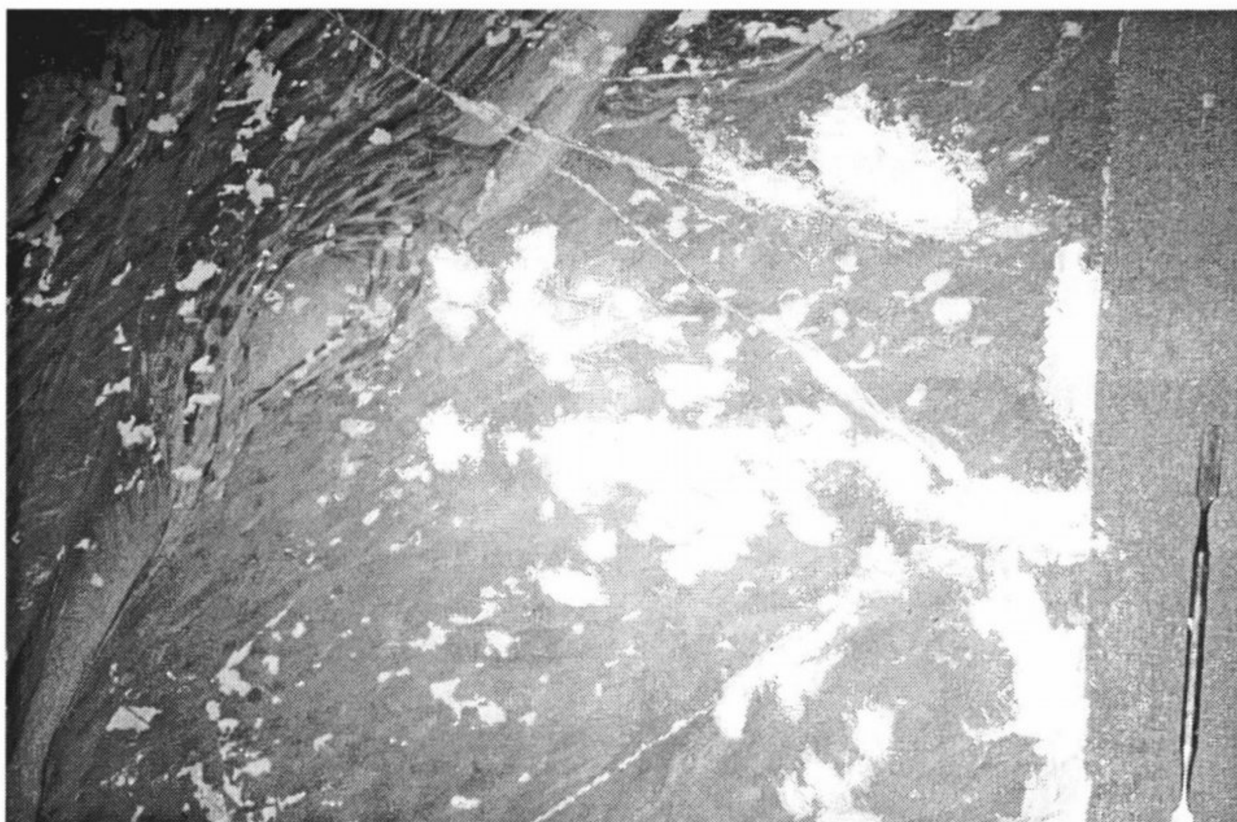
Foto 7 – Exemplo de área em fase de emassamento.
