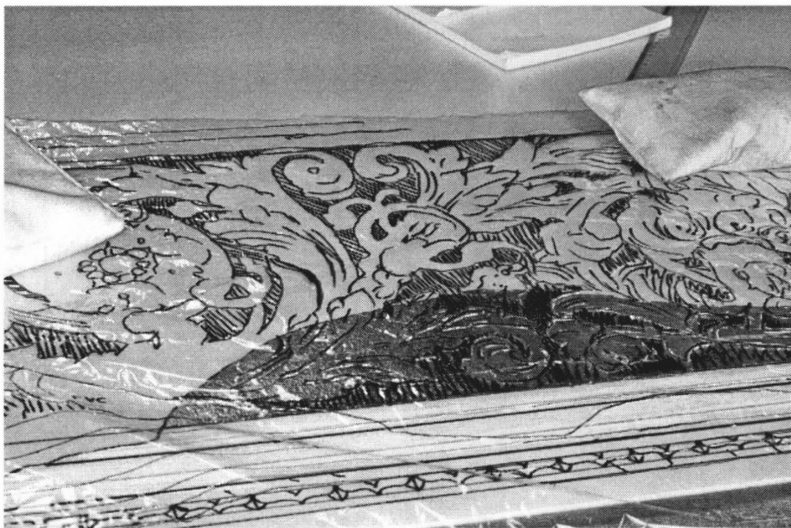
Foto 10 – Molde dos desenhos da moldura em gesso sendo rebatido para placa de polietileno .
