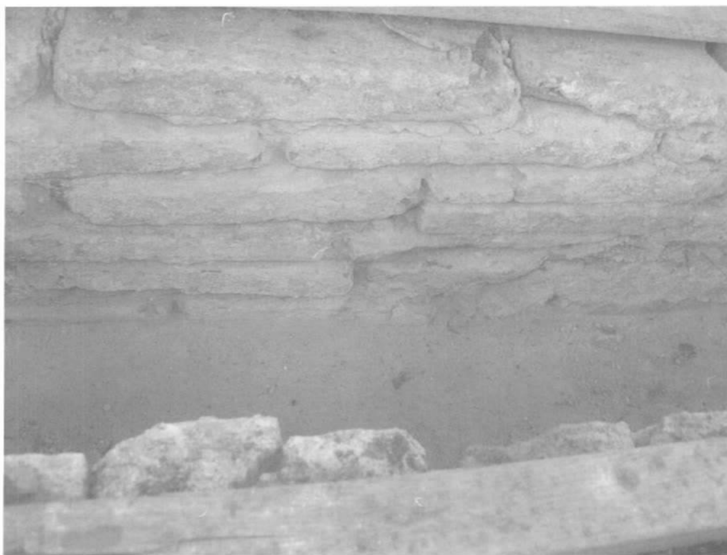
Figura 5 – Detalhe das lajotas que constituem a calha. Foto Guadalupe Campos, 2007.
