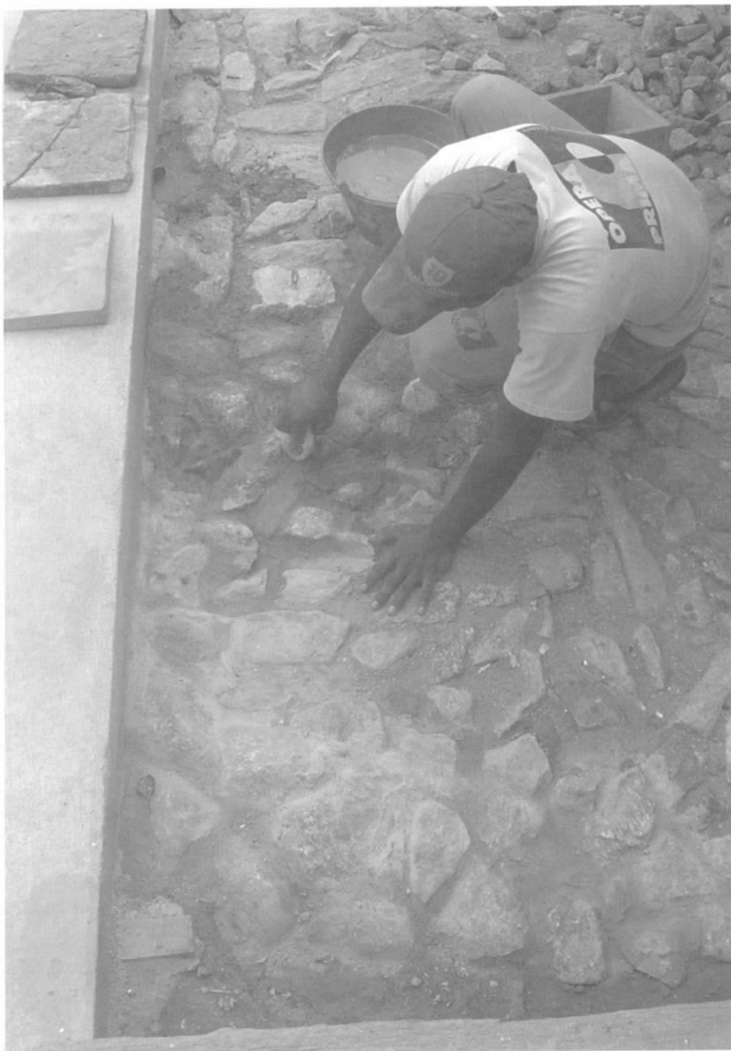
Figura 4 – Reposição do piso de pé de moleque. Foto Márcia Braga, 2007.
