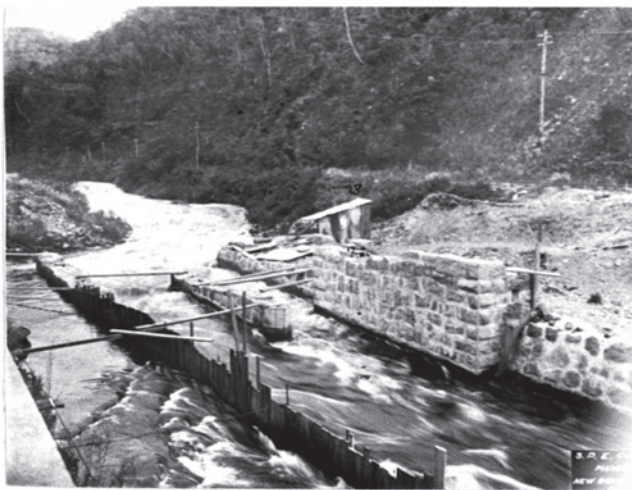
Figura 1 – Início dos trabalhos na barragem no começo da década de 1910.
