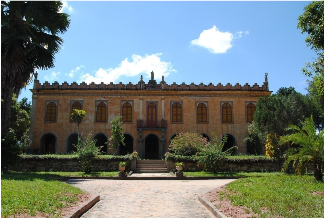
Figura 2. Fachada principal da casa da fazenda Lordelo. Foto da autora.
