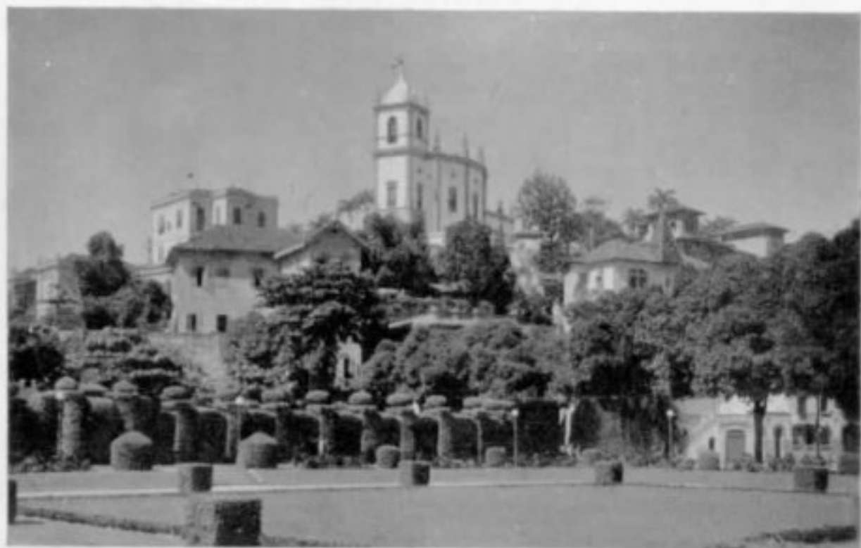
Igreja de N. S. da Glória do Outeiro Aspeto atual.
