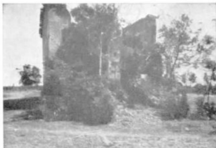
Capela de Cunhaú. Fachada. Totalmente destruída, vêem-se no chão blocos da parede, inclusive a arcada da porta principal
