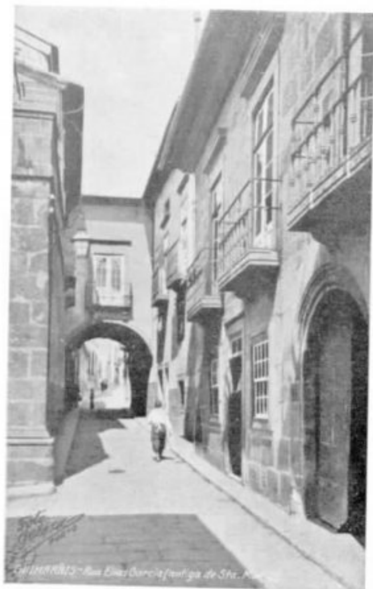
Rua Elias Garcia, antiga de Santa Maria na velha cidade de Guimarães, Portugal. A construção é idêntica à nossa, no mesmo tempo, de fins do século XVIII a meados do XIX. As mesmas vidraças de guilhotina, as mesmas bandeiras das portas, as mesmas proporções de claros e cheios, os mesmos balcões de ferro
