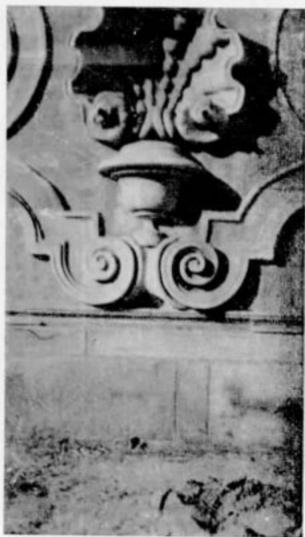
Chafariz dos Contos. A parte central restaurada pela Inspeção de Monumentos Nacionais.
