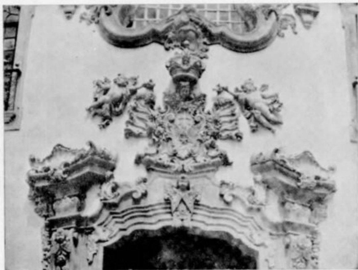
Coroamento da porta principal da igreja de N. S. do Carmo de Ouro Preto restaurado pela Inspetoria de Monumentos Nacionais.
