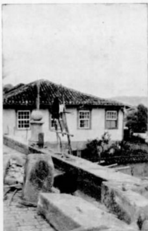
Ponte do Rosário. Restauração do lado direito.
