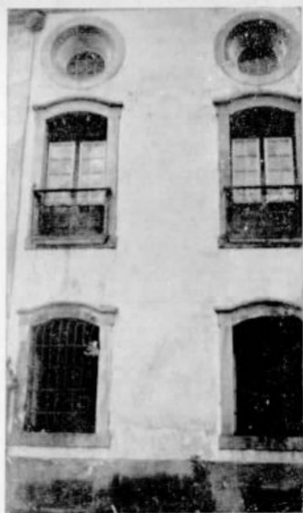
Igreja de Nossa Senhora do Carmo. Pano da fachada lateral direita como se encontrava.
