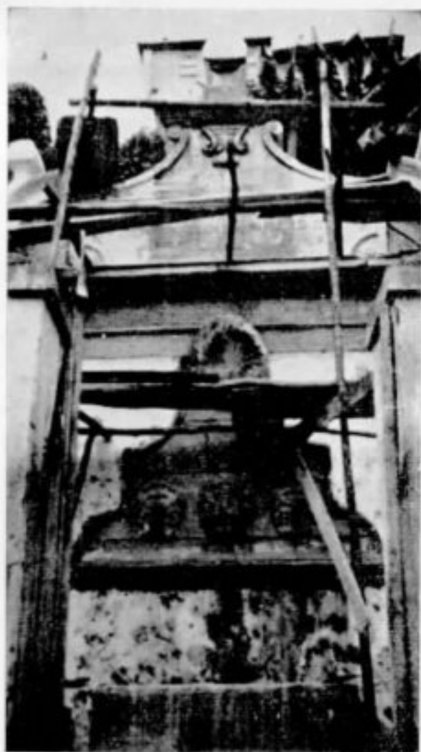
Chafariz da Glória, Ouro Preto, em obras de restauração.
