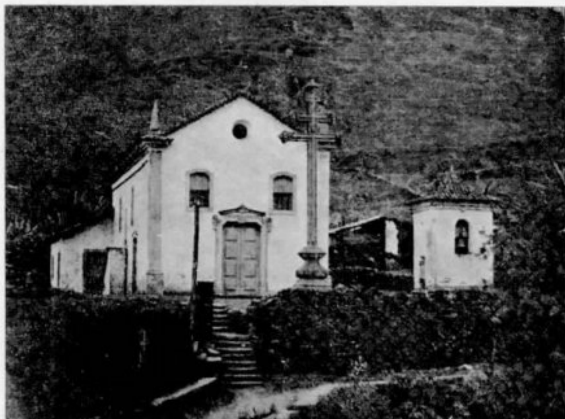
Aspecto atual da capela do Padre Faria. O frontispício barroco existente na mesma, que a Inspetoria de Monumentos Nacionais encontrou e conservou, foi retirado pelo Serviço de Patrimônio Artístico e Histórico, posteriormente.
