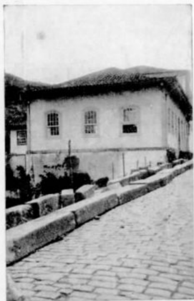
Ponte do Rosário, Ouro Preto. Trabalhos de restauro do lado direito.
