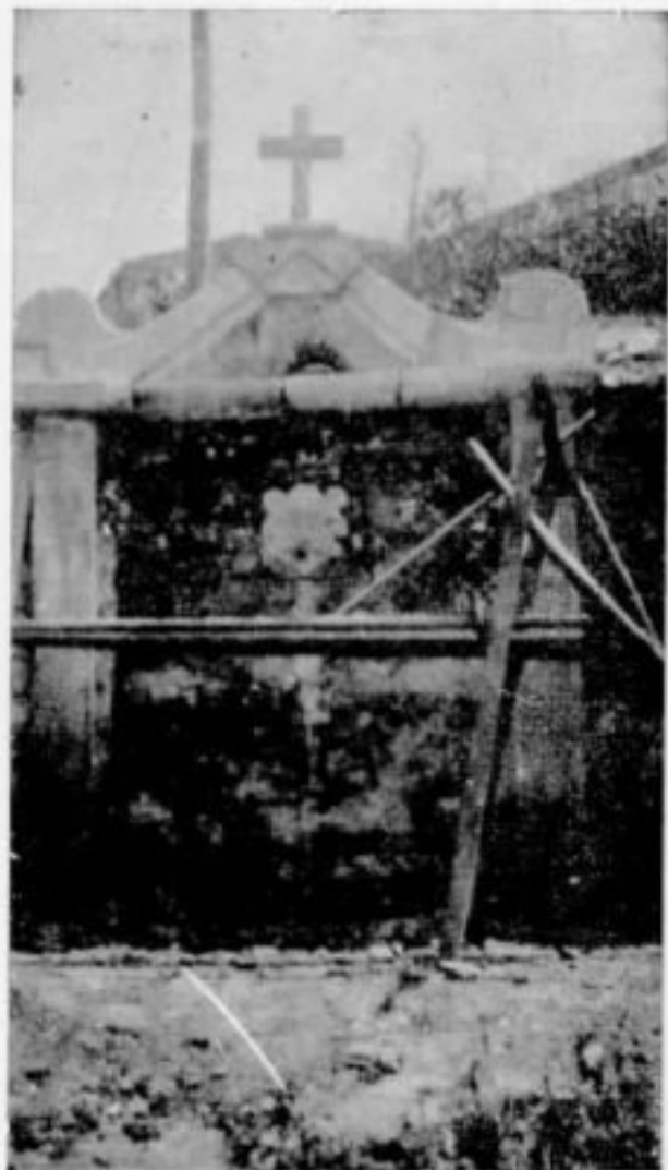
Chafariz dos Cavalos, sendo restaurado.
