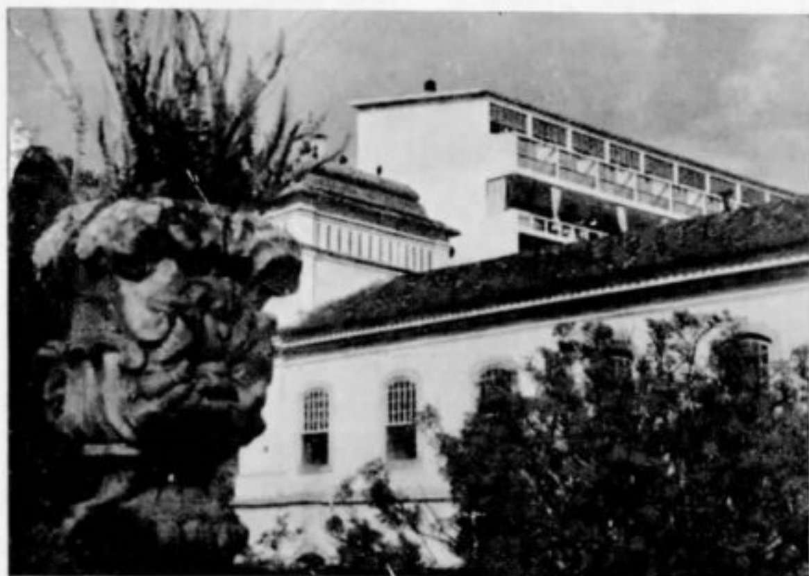
Fachada lateral da Casa dos Contos, chaminé e vaso com carranca, restaurados sob a direção do Dr. Gustavo Barroso. Por cima do telhado o edifício moderno que se vê é o hotel construído pelo Serviço do Patrimônio Histórico e Artístico Nacional.
