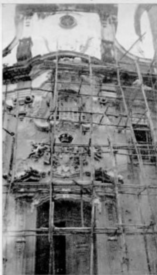
Igreja de Nossa Senhora do Carmo. Restauração da fachada principal.
