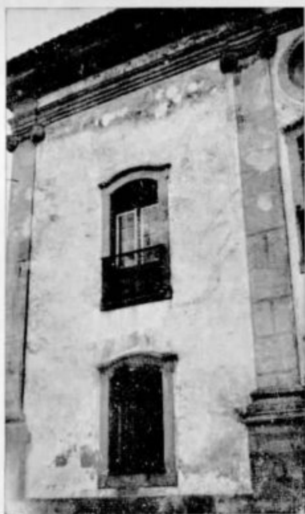
Igreja de Nossa Senhora do Carmo. Pano da fachada lateral direita como se encontrava.
