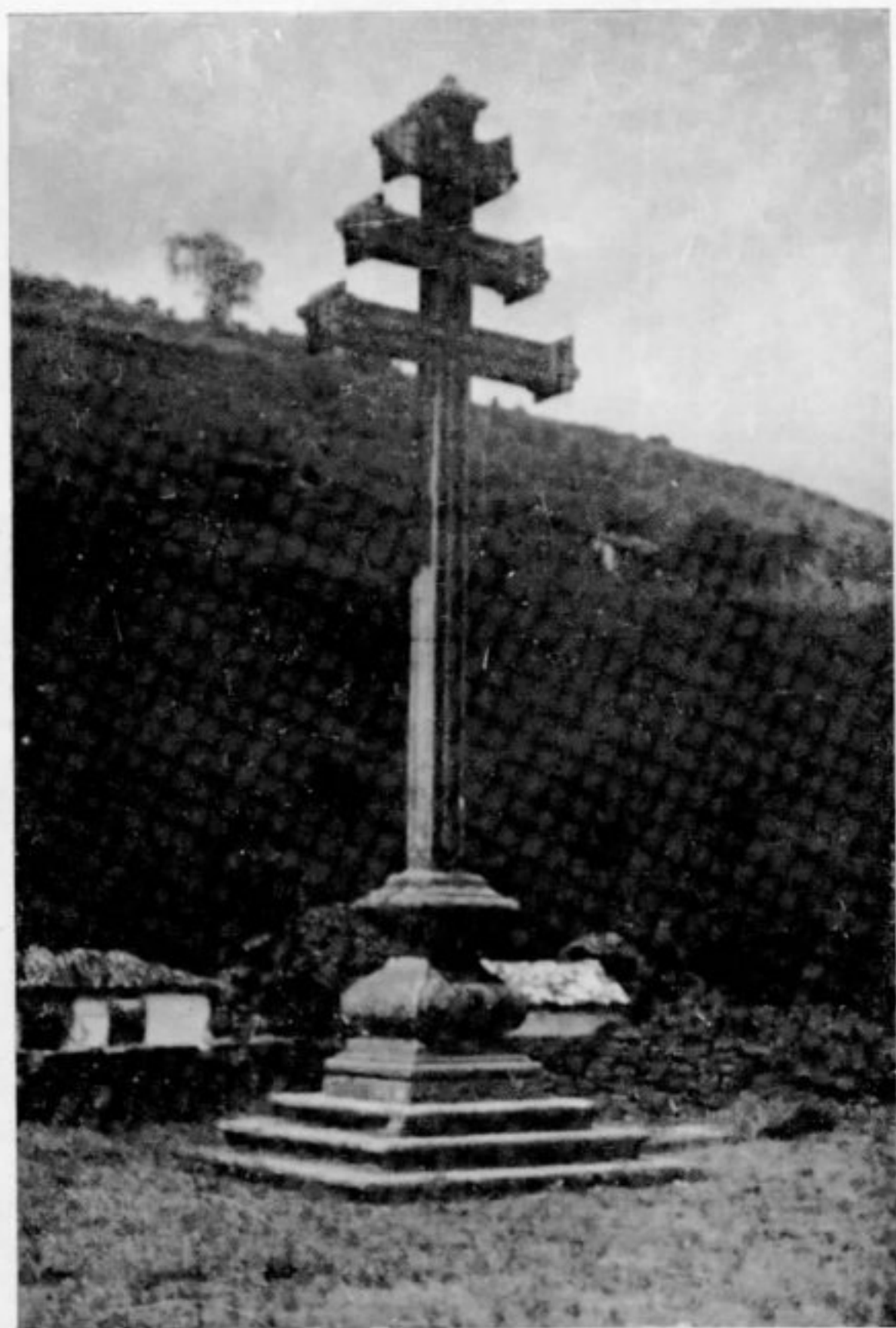
Cruzeiro da Capela do Padre Faria, Ouro Preto, depois da restauração pela Inspetoria de Monumentos Nacionais.
