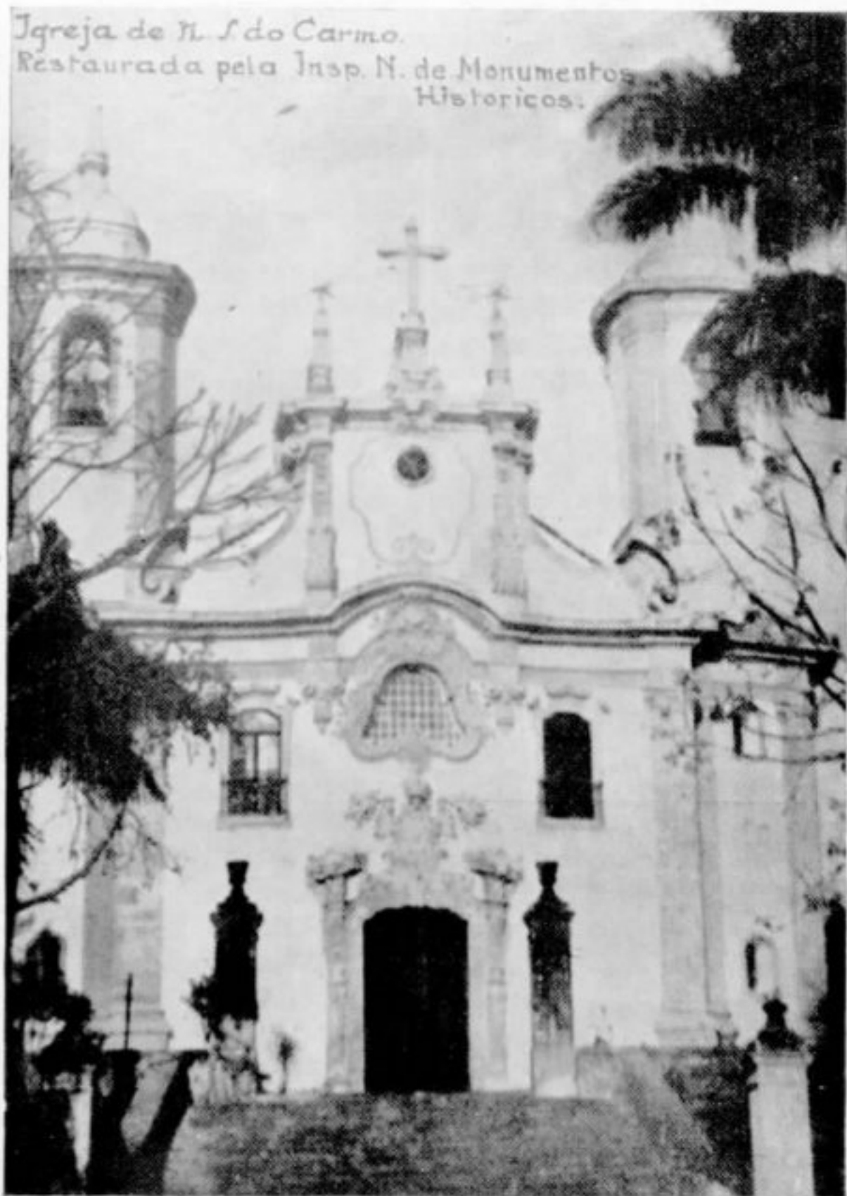
Igreja de N. S. do Carmo. Restaurada pela Insp. N. de Monumentos Históricos.
