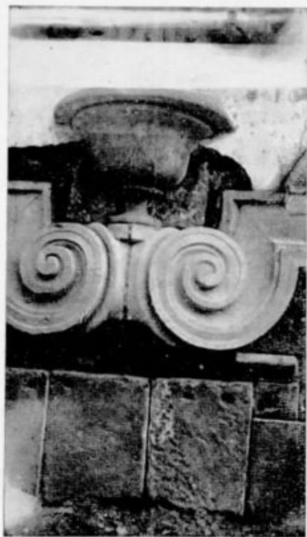
Chafariz dos Contos. Começo do restauro da parte central.
