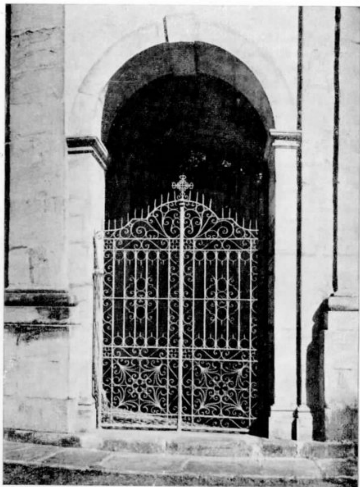
Grade de ferro da galilé da Igreja do Rosário de Ouro Preto, colocada pela Inspetoria de Monumentos Nacionais.
