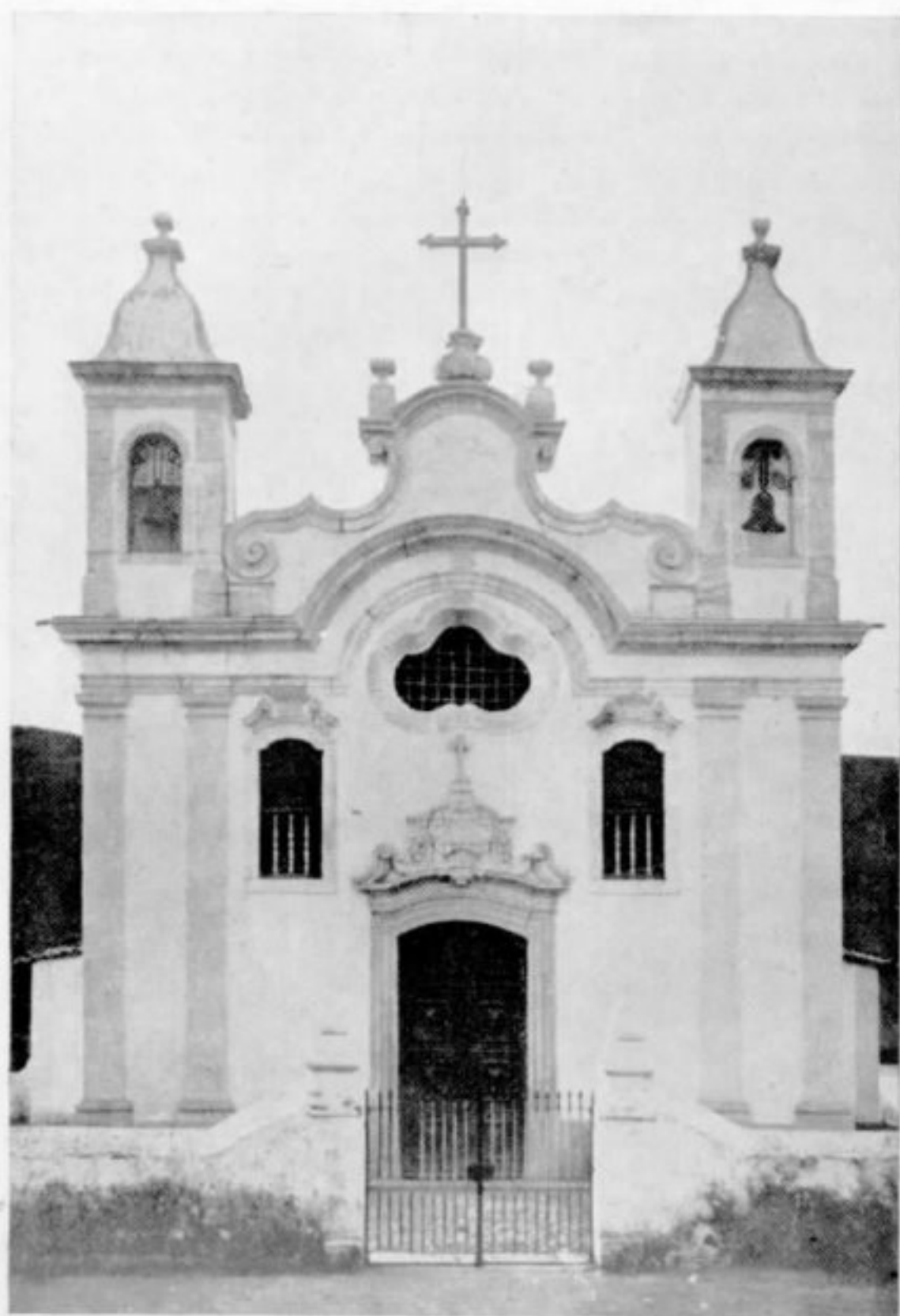
Igreja das Mercês de Baixo de Ouro Preto, depois das obras realizadas pela Inspetoria de Monumentos Nacionais.
