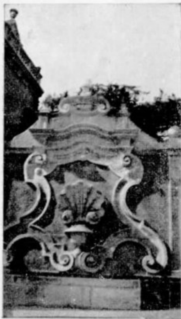
Chafariz dos Contos, devidamente restaurado.
