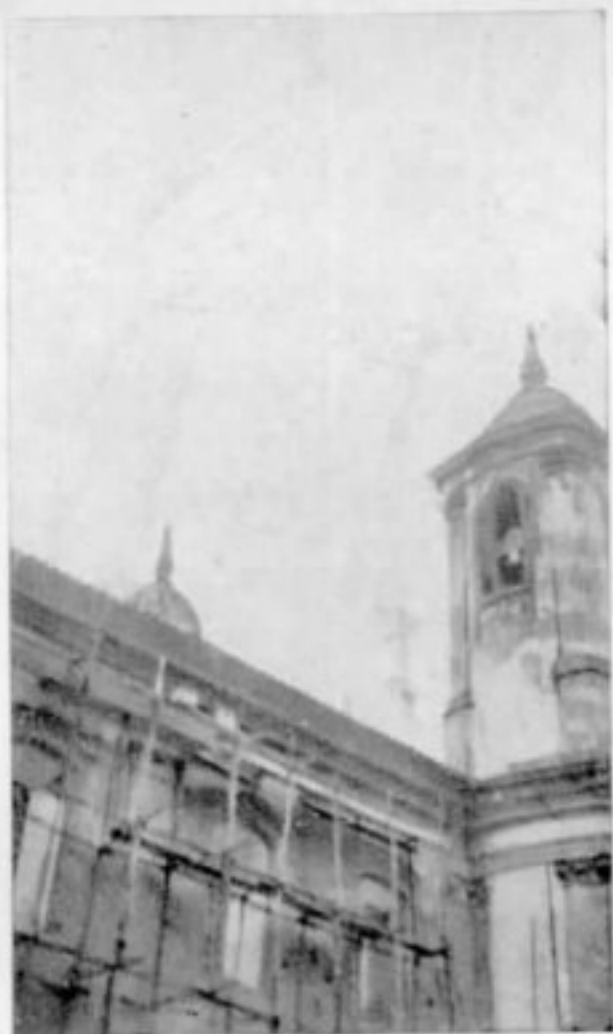
Igreja de Nossa Senhora do Carmo. Estado da tórre e fachada de lado direito antes da restauração.
