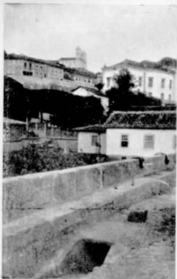
Ponte do Rosário. Lado esquerdo. Restauração do bueiro.
