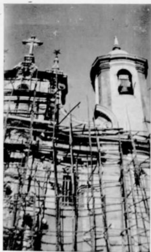
Igreja de Nossa Senhora do Carmo. Fachada principal quase recomposta. A torre do lado esquerdo restaurada.
