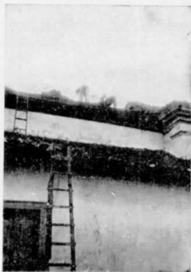
Capela do Padre Faria. Recomposição do telhado pela Inspetoria de Monumentos Nacionais.
