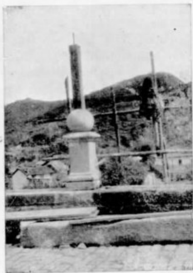
Ponte do Rosário. Montagem da cruz, do lado direito.
