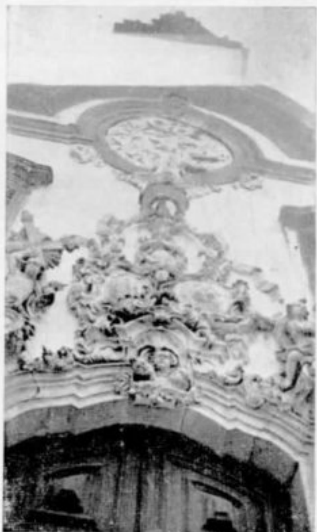
Igreja de Nossa Senhora do Carmo. A porta principal e o frontispício restaurados.
