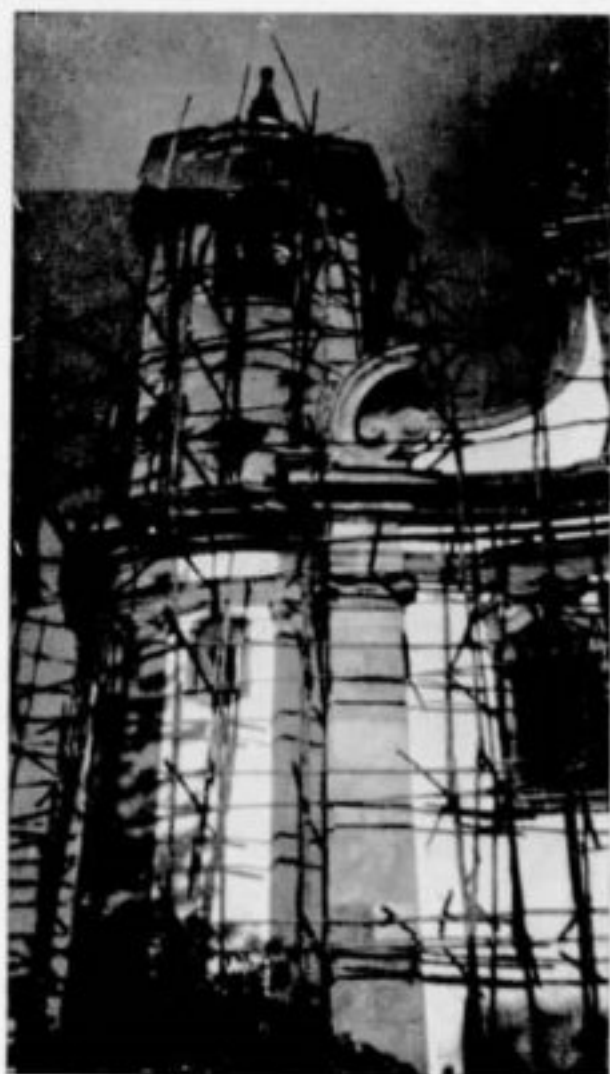
Igreja de Nossa Senhora do Carmo. Trabalhos de restauração da torre do lado esquerdo.
