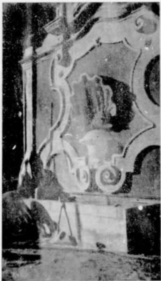
Chafariz dos Contos, restaurado com o seu tanque de pedra.
