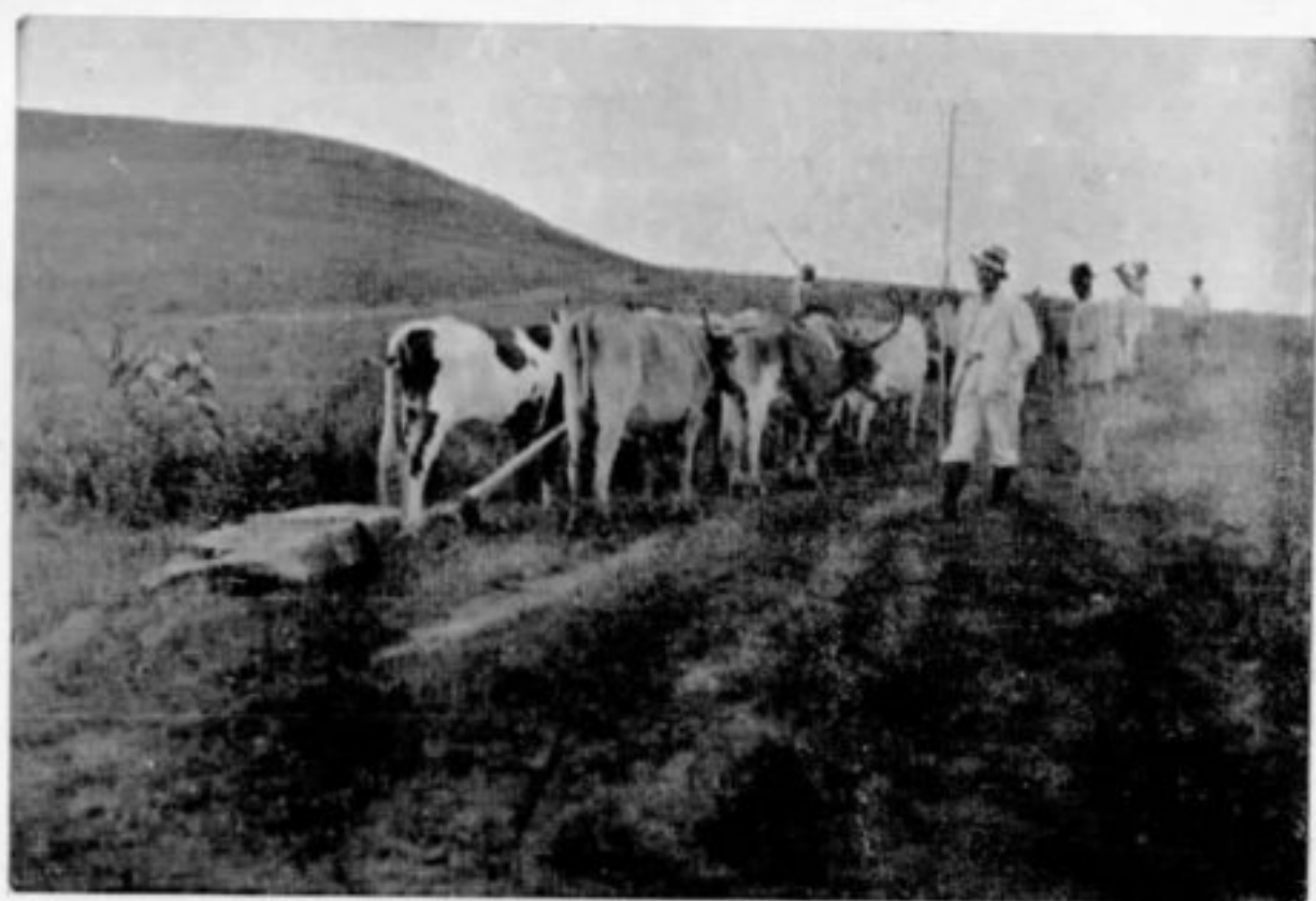
Pedreira do Itacolomi. Os bois arrastam as pedras abandonadas desde os tempos coloniais para as obras da Inspeção de Monumentos Nacionais, em Ouro Preto. No 1.º plano, empunhando a vara de ferrão, o Engenheiro Epaminondas Maceda.
