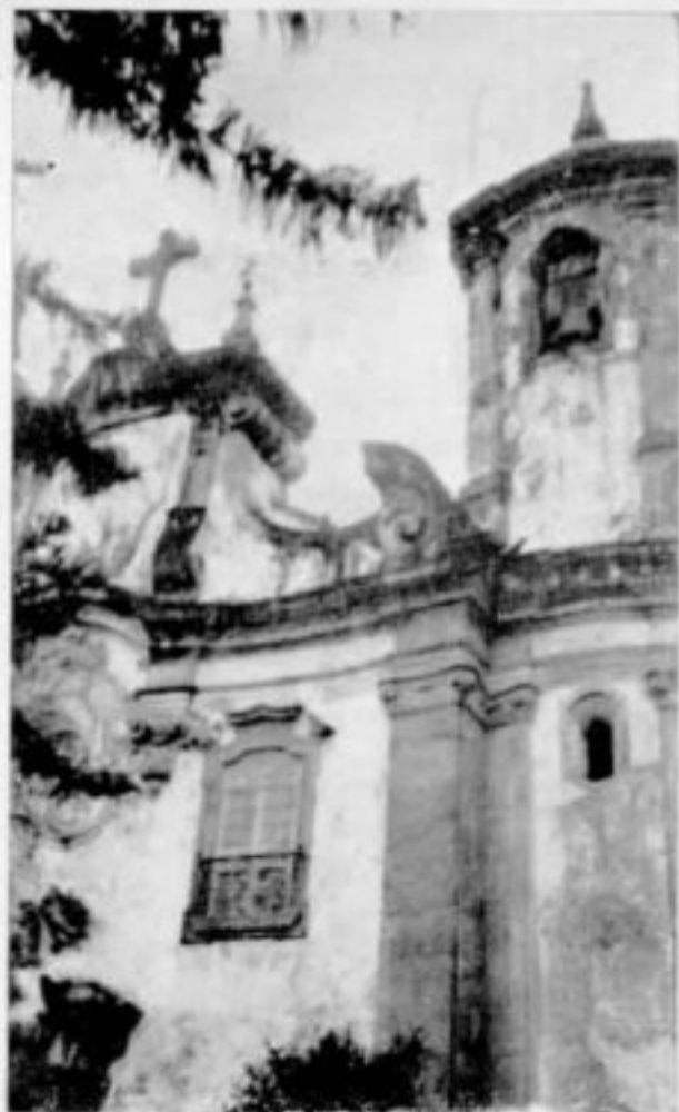
Igreja de Nossa Senhora do Carmo. Estado em que se achava a torre do lado esquerdo.
