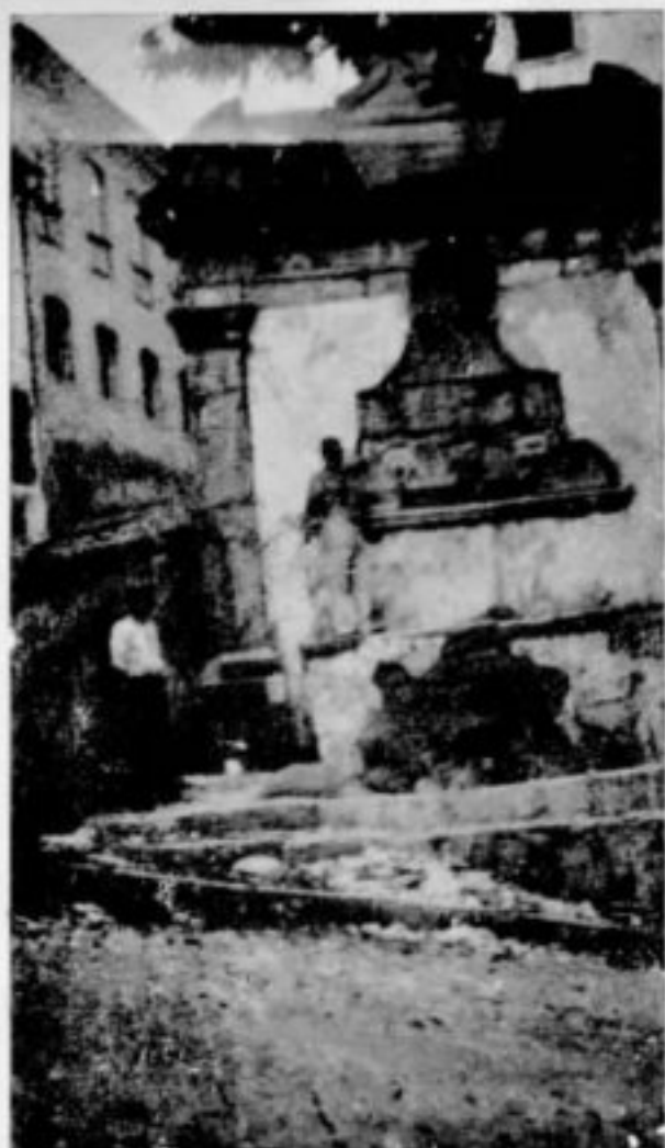
Chafariz do Passo de Antônio Dias, Ouro Preto, quase em ruína.
