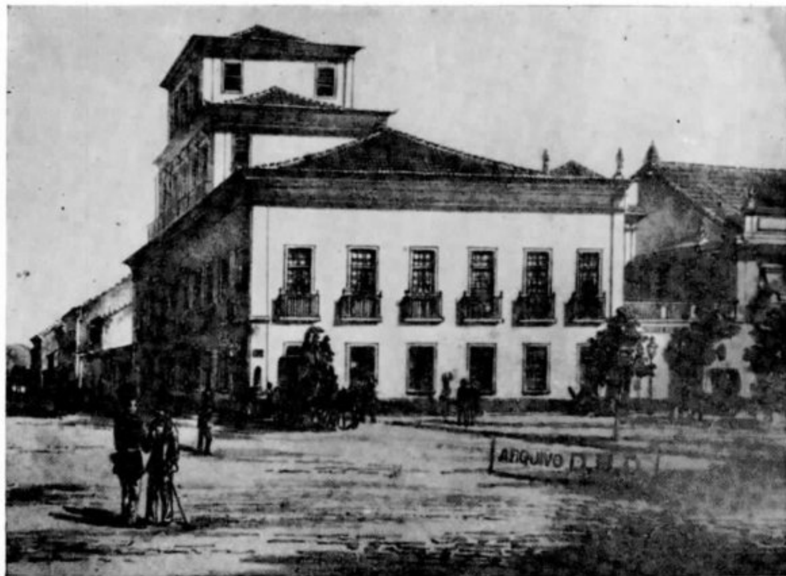
Prédio do Club Fluminense, à Praça da Constituição (atual Tiradentes), onde Machado de Assis, segundo declaração própria, jogava xadrez.
