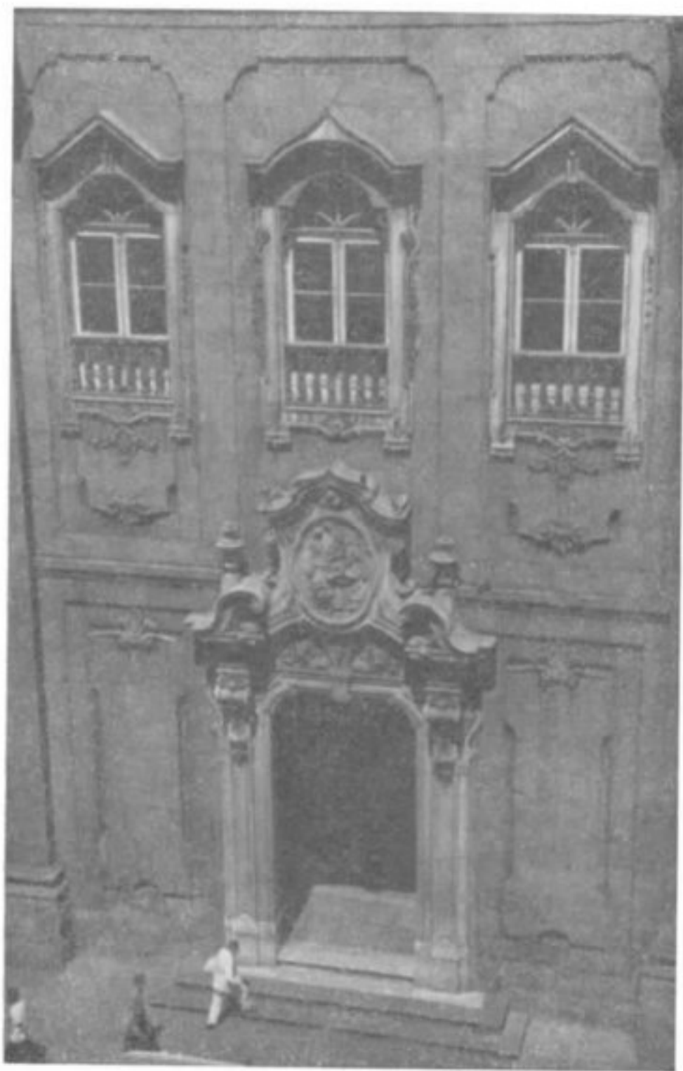
Parte da fachada da Igreja do Carmo
