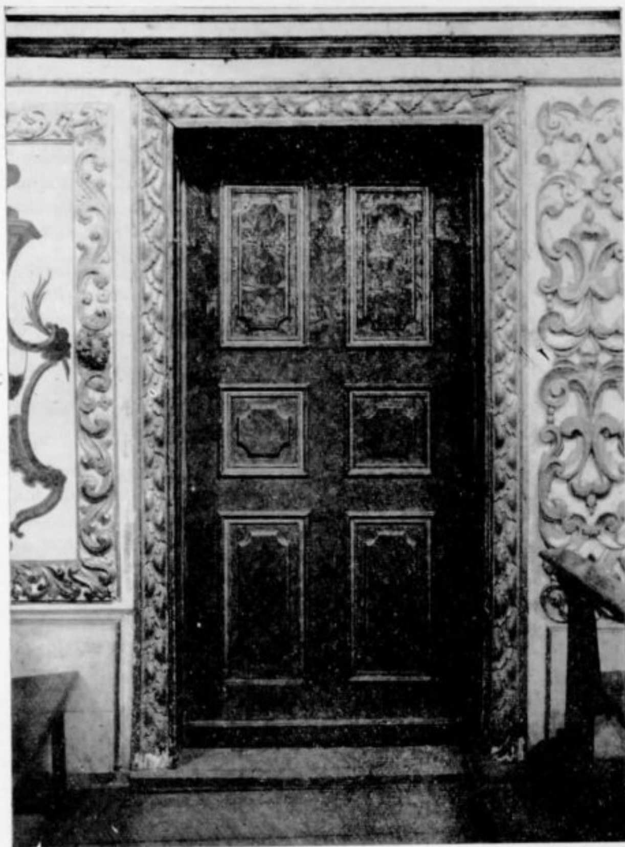
Matriz de Sabará — MG. Porta com pintura em estilo chinês. Foto E. C. Falcão.
