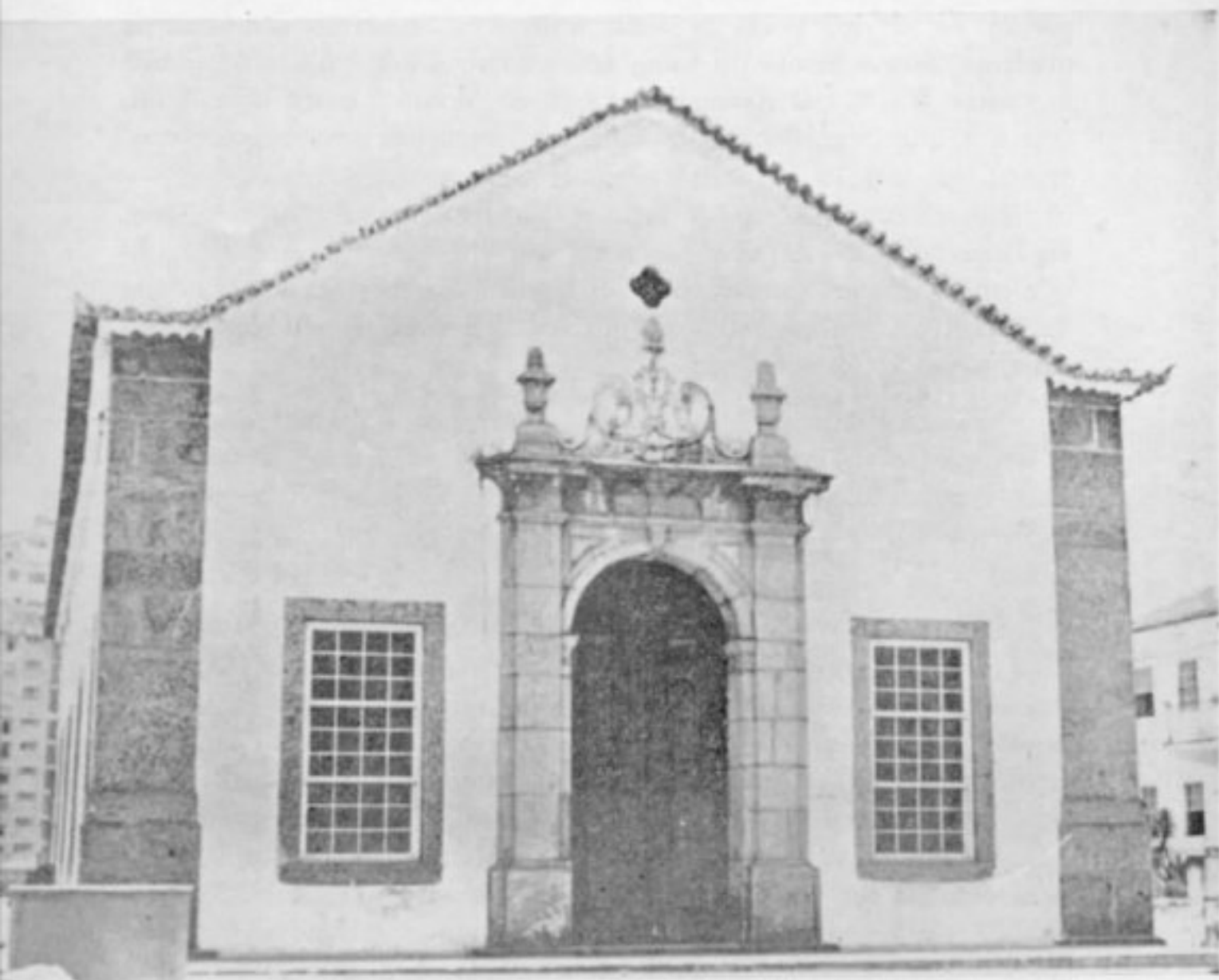
Forte da Conceição — Casa das Armas (estado atual)
